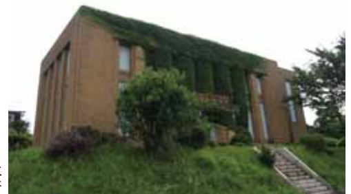
第一配水ポンプ所
